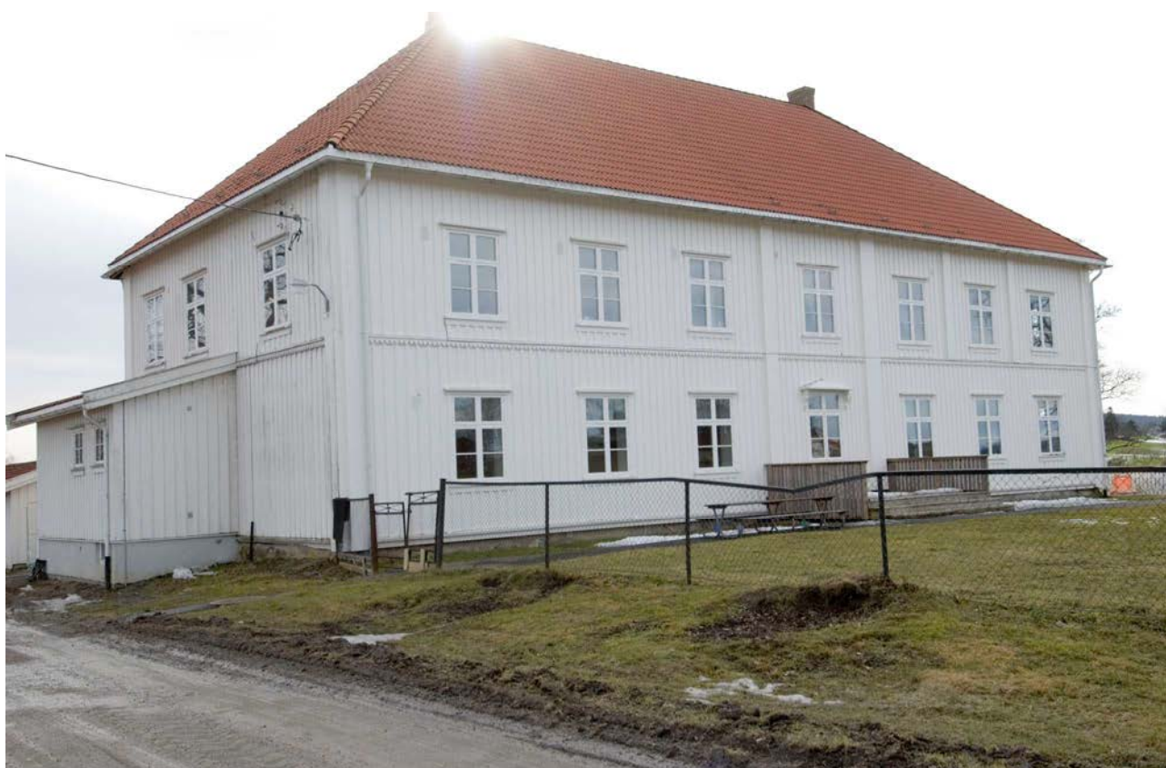
Hovedbygningen på Nordli
