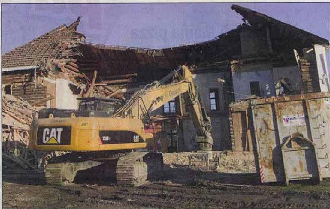
TRE UKER STANS: Er du, herr ordfører, fortsatt like sikker på at du hadde så dårlig tid at riving måtte startes omgående etter kommunestyrevedtaket spør innsenderen.
